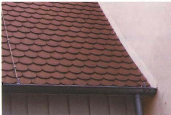
Dachanschluß an Mauerwerk
