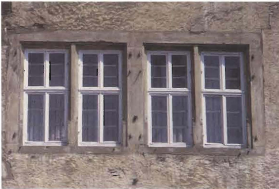
Historische Fensterreihe am ehemaligen Amtshaus
