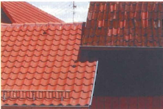
Moderne Hohlfalzziegel und historische Pfannendeckung
