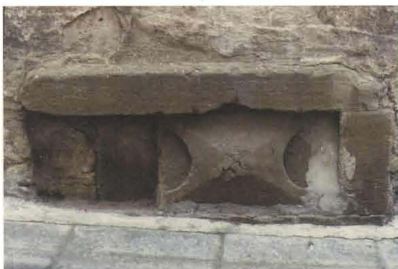
An verschiedenen Kellerfenstern im Ort finden sich noch solche Steinschiebeläden, als Besonderheit sind sie zu erhalten.
