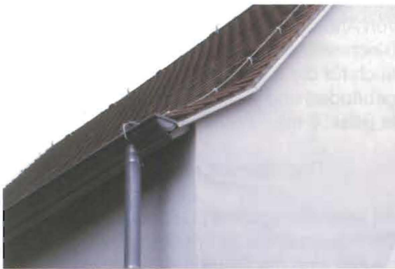
Ortgang und Traufe in richtiger Konstruktion
