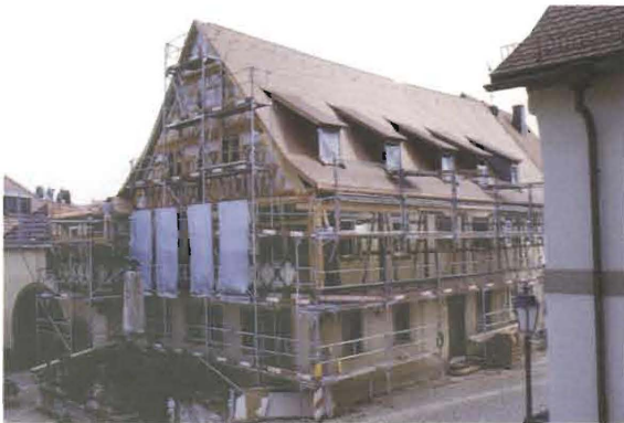
Fachwerkrestaurierung am Gasthaus Grüner Baum
