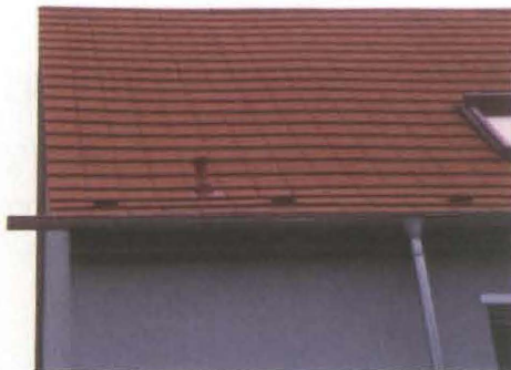
Deckung mit Bieberschwanzziegel mit rechteckigem Schnitt
