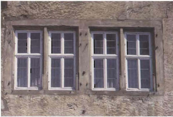
Historische Fensterreihe am ehemaligen Amtshaus
