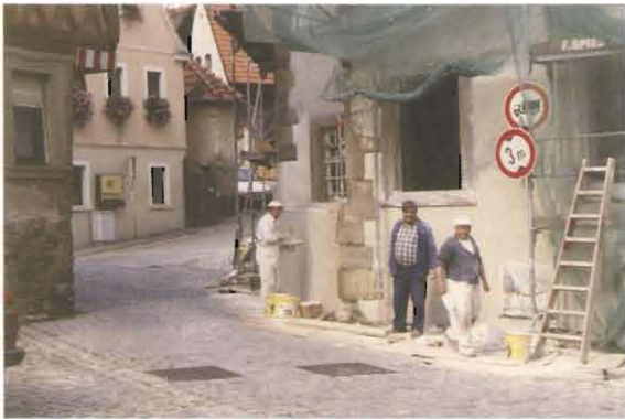
Sanierungsarbeiten am ehemaligen Würzburger Amtshaus
