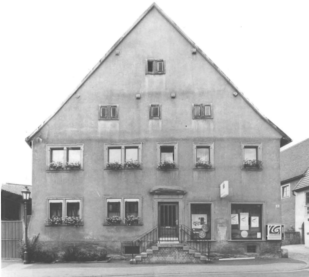
So sah das Gebäude vor der Renovierung aus.
